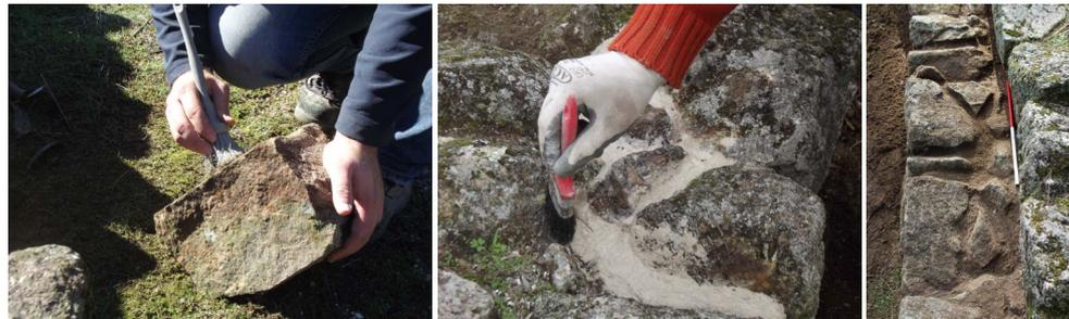
Paralelamente, proceder-se-á à reposição dos níveis de cota originais nas áreas junto às estruturas com défice ao nível do alicerce das mesmas. Por fim, concluídas as ações de correção de estruturas e regularização pontual de pisos será ainda efetuada a sua consolidação e proteção superficial.
